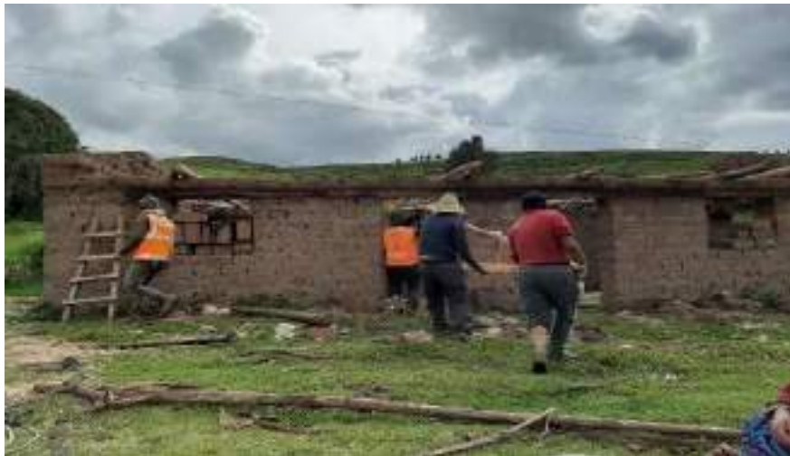
Figura N° 02 Techado de la casa en el Ayni
