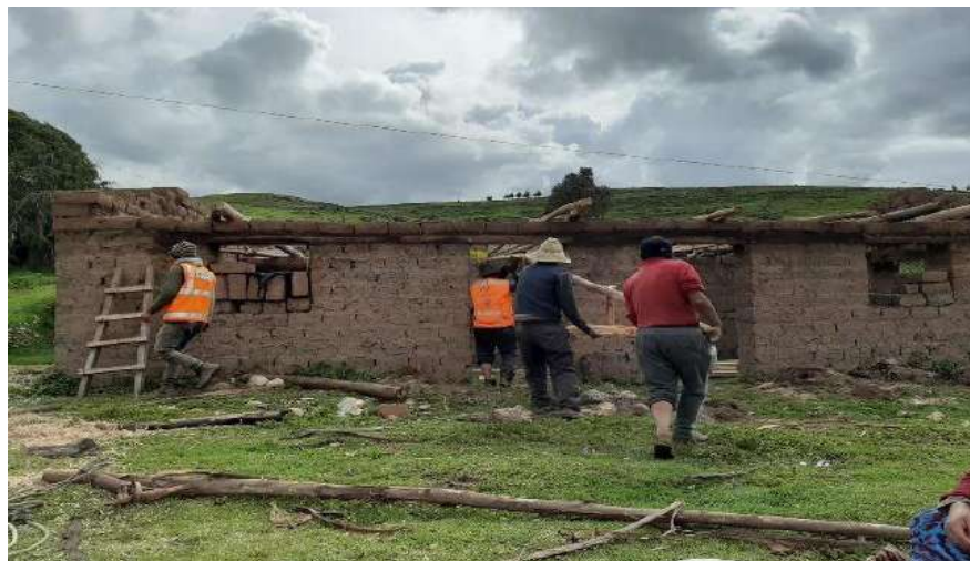
Figura N° 02 Techado de la casa en el Ayni
